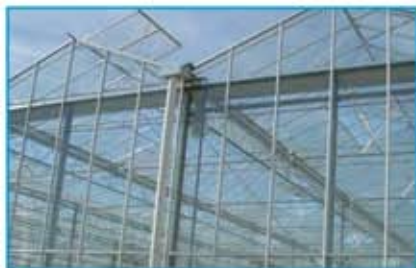
Rännan ligger på ovansidan av fackverket
